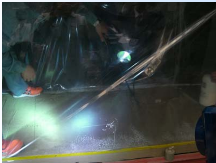
写真 - 20 撒布状況
