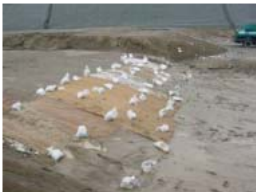
即日覆土代替材台風通過後状況(施工直後)
