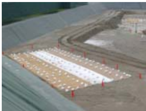
中間覆土代替材台風通過後状況(施工直後)
