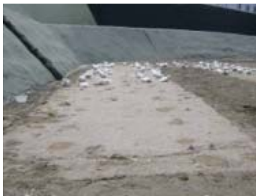
中間覆土代替材6ヶ月経過状況
