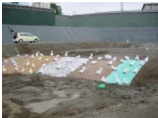
即日覆土代替材施工後状況
