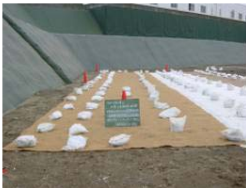
中間覆土代替材施工後状況
