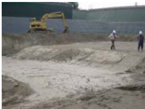
即日覆土代替材3ヶ月経過状況
